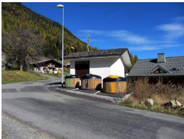
Point de collecte des déchets
