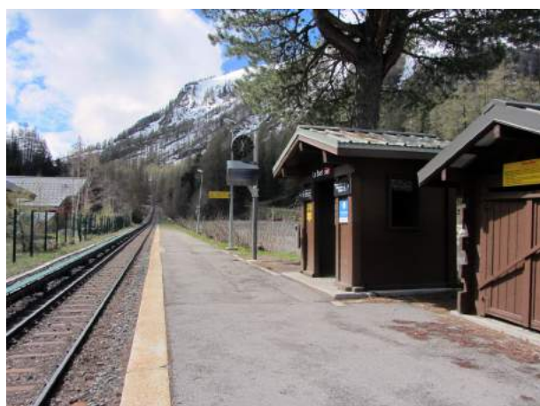
Halte ferroviaire et équipements périphériques existants
