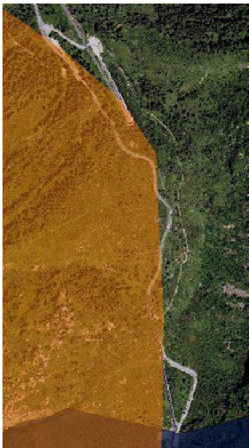
Infrastructures existantes à l'aval du col des Montets et périmètre du site Natura 2000 des Aiguilles Rouges
