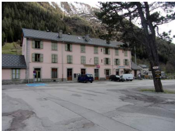
Bâtiment de la gare ferroviaire et parking
