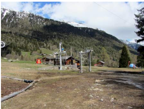
Domaine skiable de la Poya et situation de l'ER n° 6 au départ des remontées mécaniques
